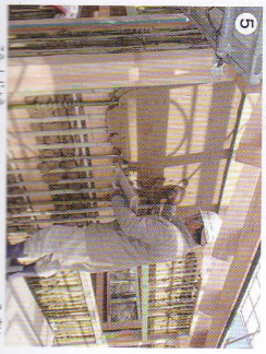
6 慎重に柱を立て、組み上げる。
