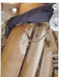
2 内冠木や2階の梁に用いられたマツ材は手斧で仕上げる。
